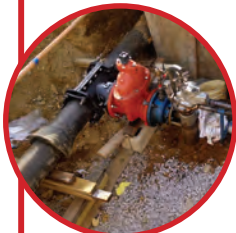
16" X 16" Wet Tap on DI Water Line
